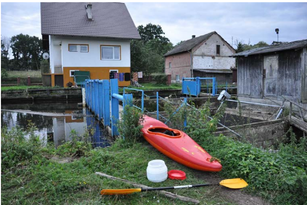
Fot. 18. Przenoska przy małym obiekcie hydrotechnicznym (jazie), Łeba
