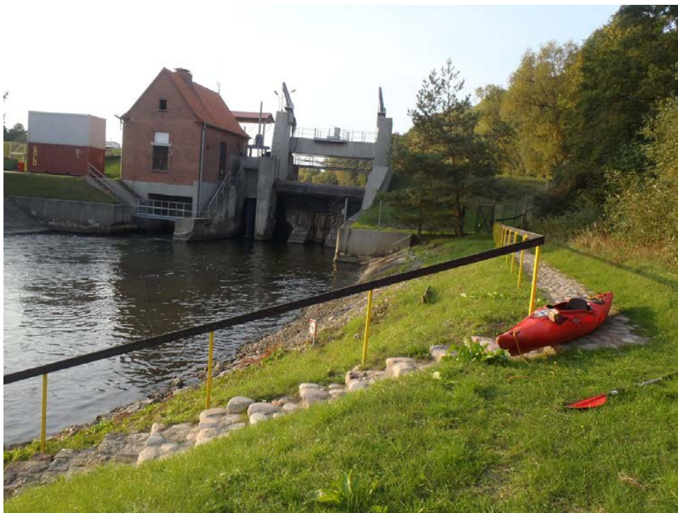
Fot. 17. Dolna przenoska przy elektrowni wodnej Juszkowo na Raduni
