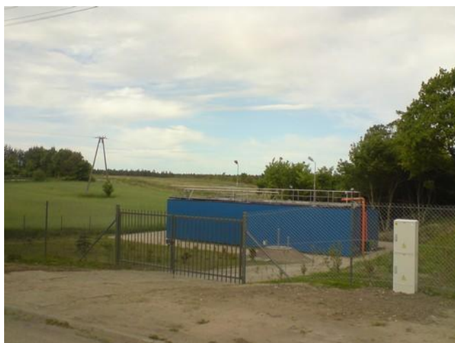
Oczyszczalnia ścieków (2008-2009r.)
