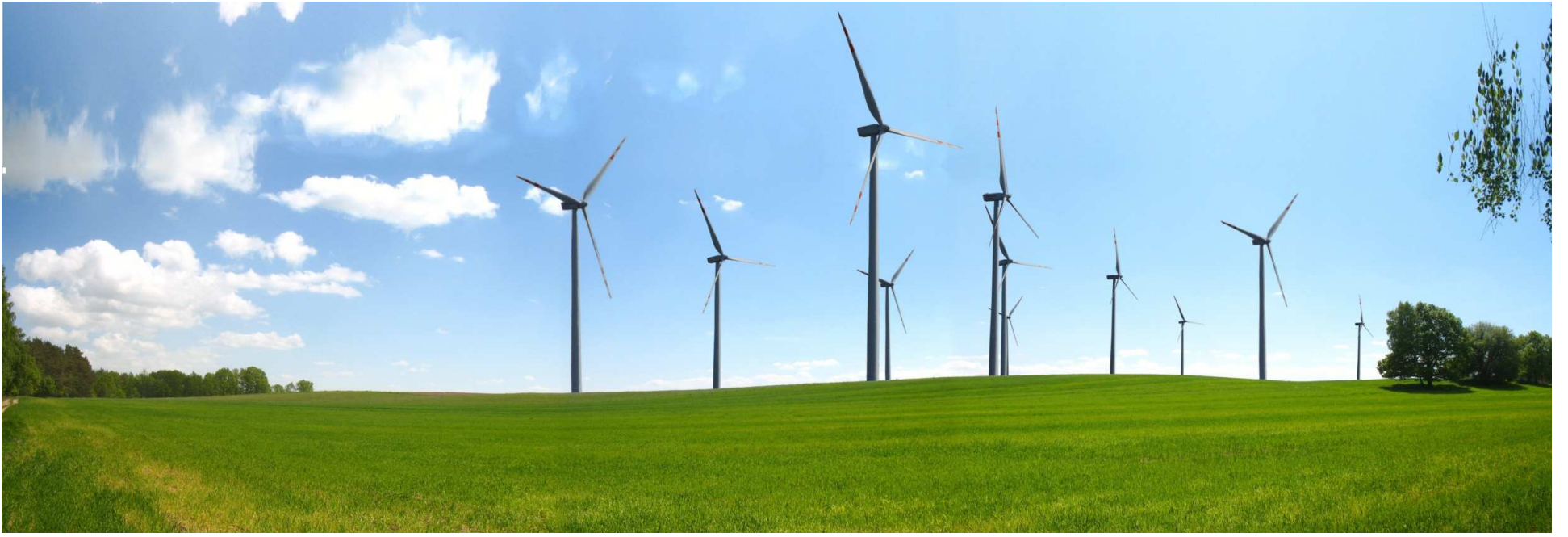
Fot. 1 Widok na część IA obszaru „Planu ...” z północnego-wschodu, z okolic wsi Drzeżewo – w głębi wmontowane sylwety elektrowni wiatrowych zespołu „Drzeżewo I” (poza obszarem „Planu ...”)
