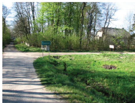
Fot. 8 Skrzyżowanie drogi powiatowej 1137G i drogi gminnej (z prawej)
