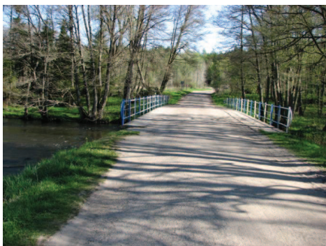
Fot. 7 Most na Łupawie w ciągu drogi powiatowej 1137G
