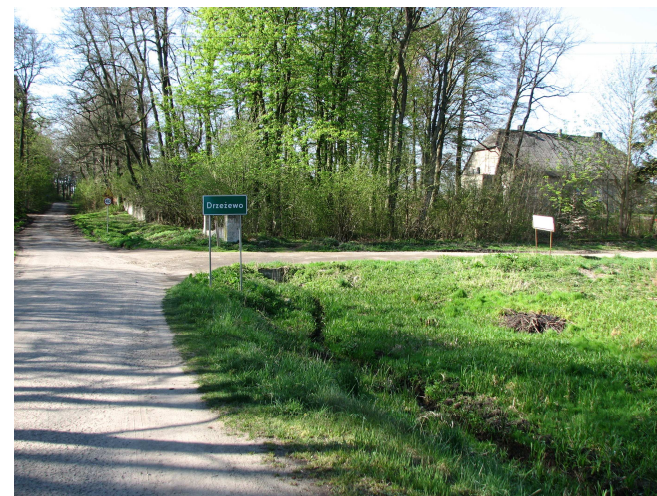
Fot. 8 Skrzyżowanie drogi powiatowej 1137G i drogi gminnej (z prawej)
