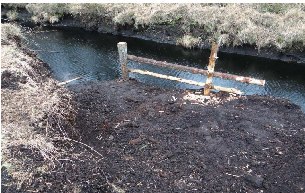
Fot. 1. Niwelacja terenu umożliwiającą zwierzętom wydostanie się z rowu
