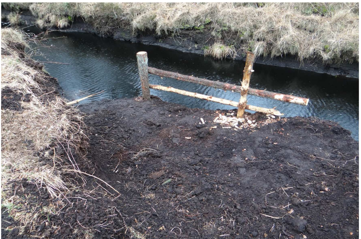
Fot.23 Niwelacja terenu umożliwiającą zwierzętom wydostanie się z rowu
