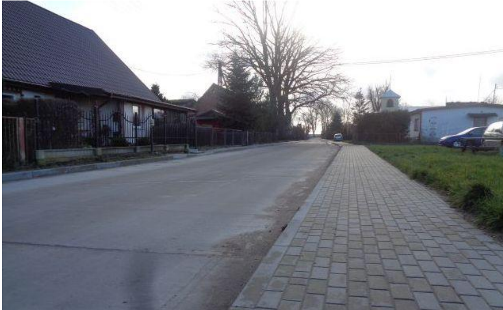
Przebudowa drogi powiatowej w Szczypkowicach
