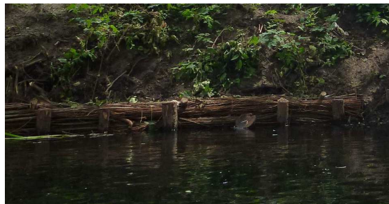
(fot.35) Umocnienia faszynowe
