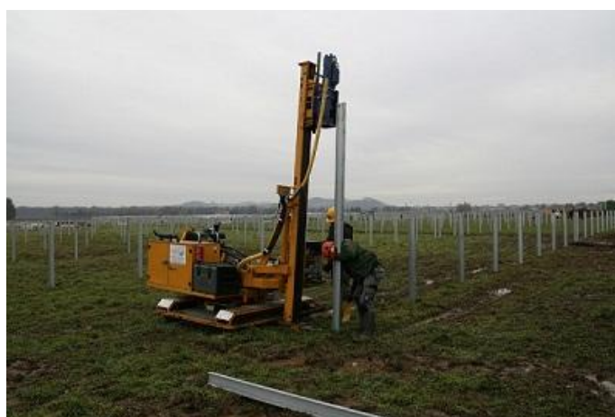
Fot. 4. Montaż konstrukcji wsporczych ogniw fotowoltaicznych
