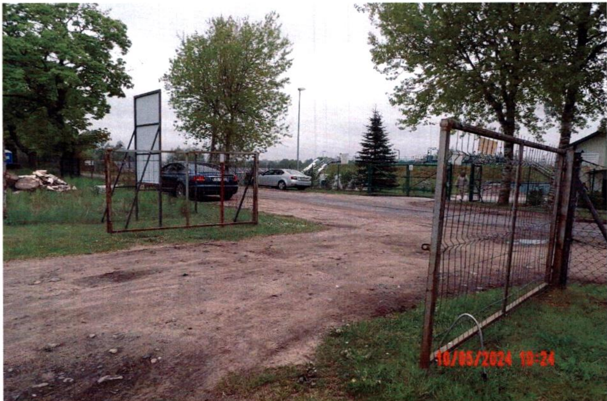
Zdj. nr 3 -zamykana brama wjazdowa na ogrodzony teren PSZOK
