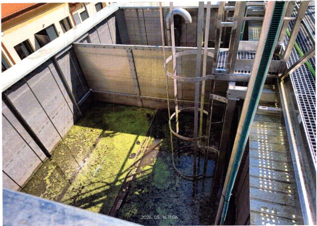
Zdjęcie nr 10. Nieczynny reaktor biologiczny – SBR 1
