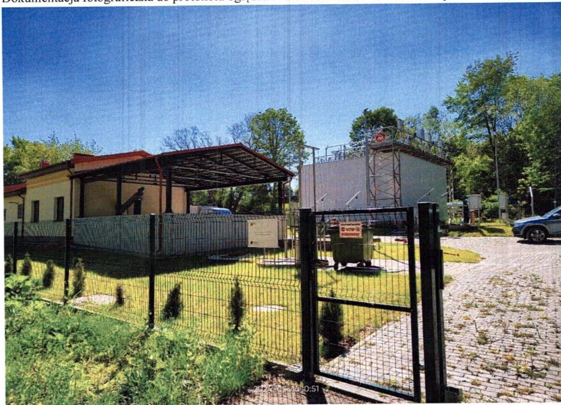
Zdjęcie nr 1. Teren oczyszczalni ścieków w Zgojewie
