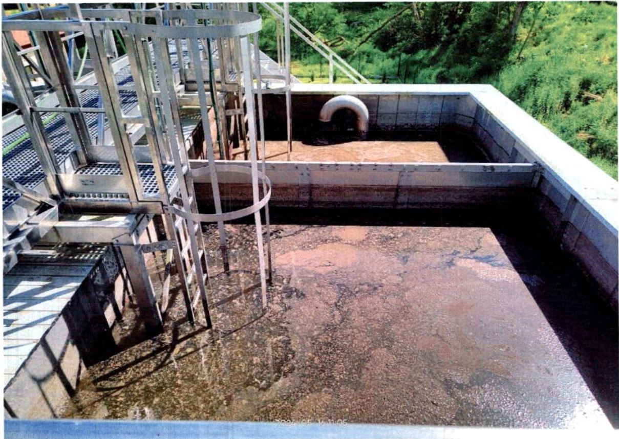
Zdjęcie nr 9. Czynny reaktor biologiczny – SBR 2
